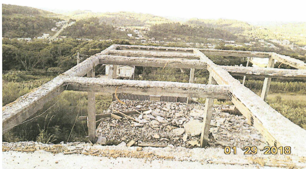
Foto 02 – Demolição Edificação Lote 09 – Quadra F
