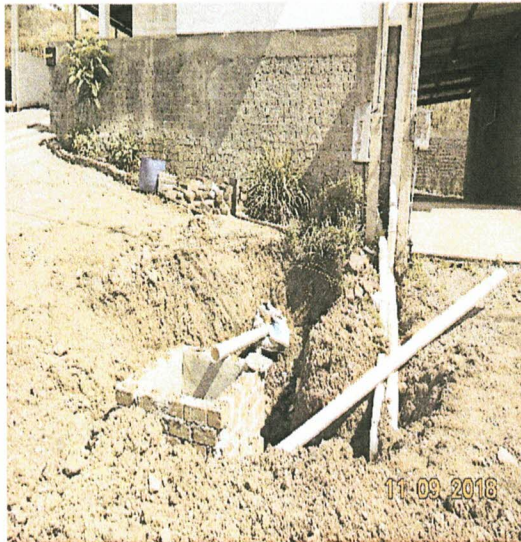
Fotos 13 e 14 – Execução da rede de esgoto
