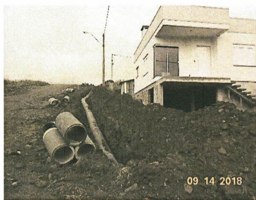
Fotos 9 e 10 – Execução da rede drenagem pluvial
