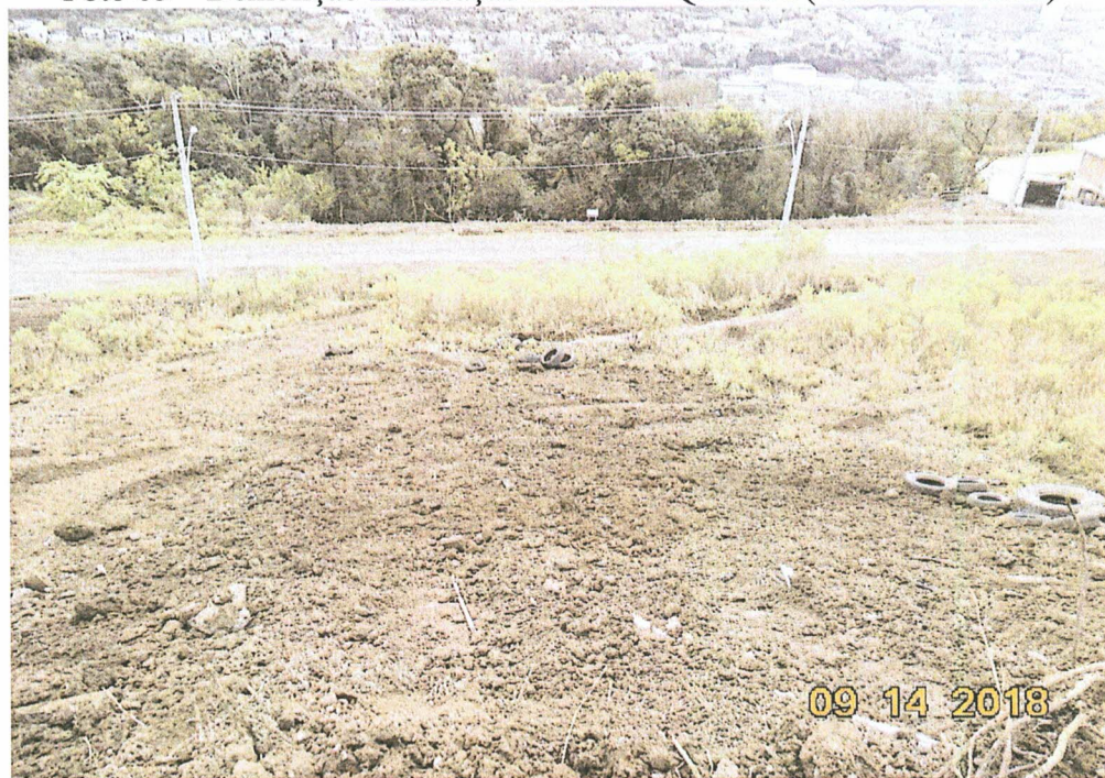
Foto 06 – Demolição Edificação Lote 12 – Quadra F(Vanderlei Nadin)
