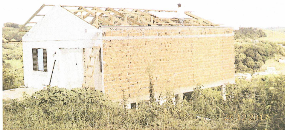
Foto 01 – Demolição Edificação Lote 09 – Quadra F
