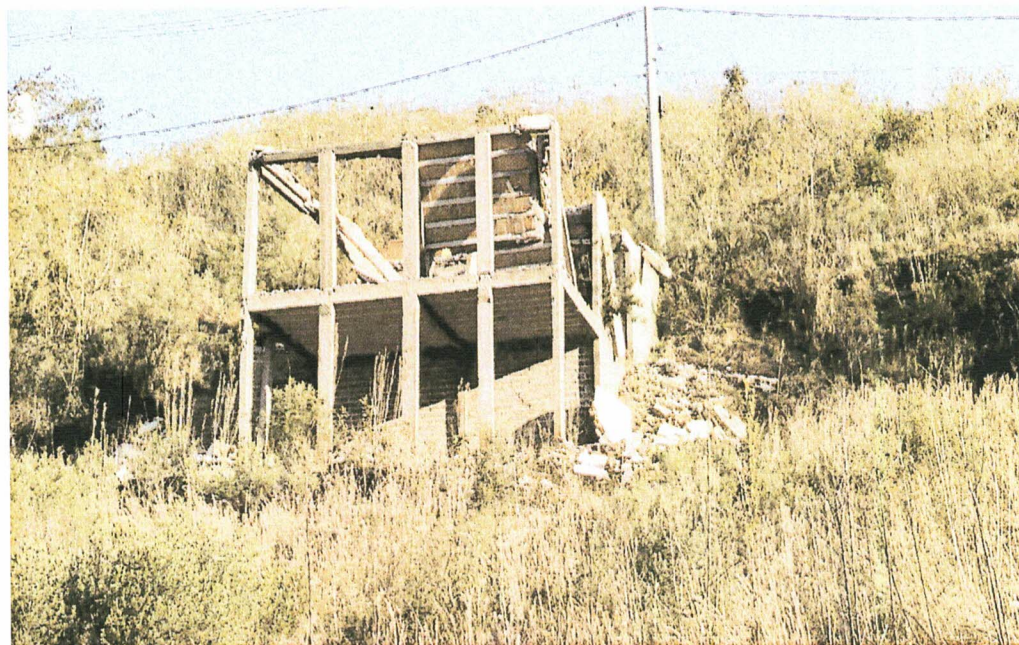
Foto 05 – Demolição Edificação Lote 12 – Quadra F(Vanderlei Nadin)
