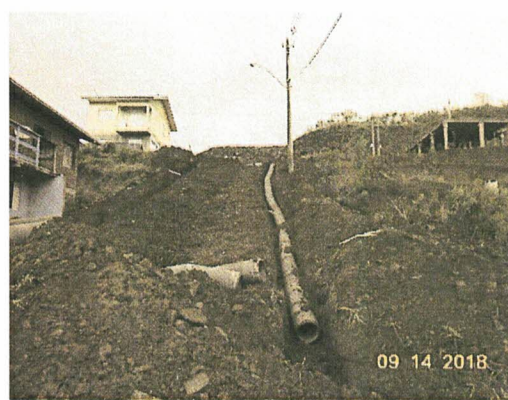
Fotos 9 e 10 – Execução da rede drenagem pluvial
