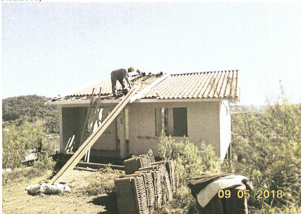
Foto 04 – Demolição Edificação Lote 12 – Quadra F(Vanderlei Nadin)
