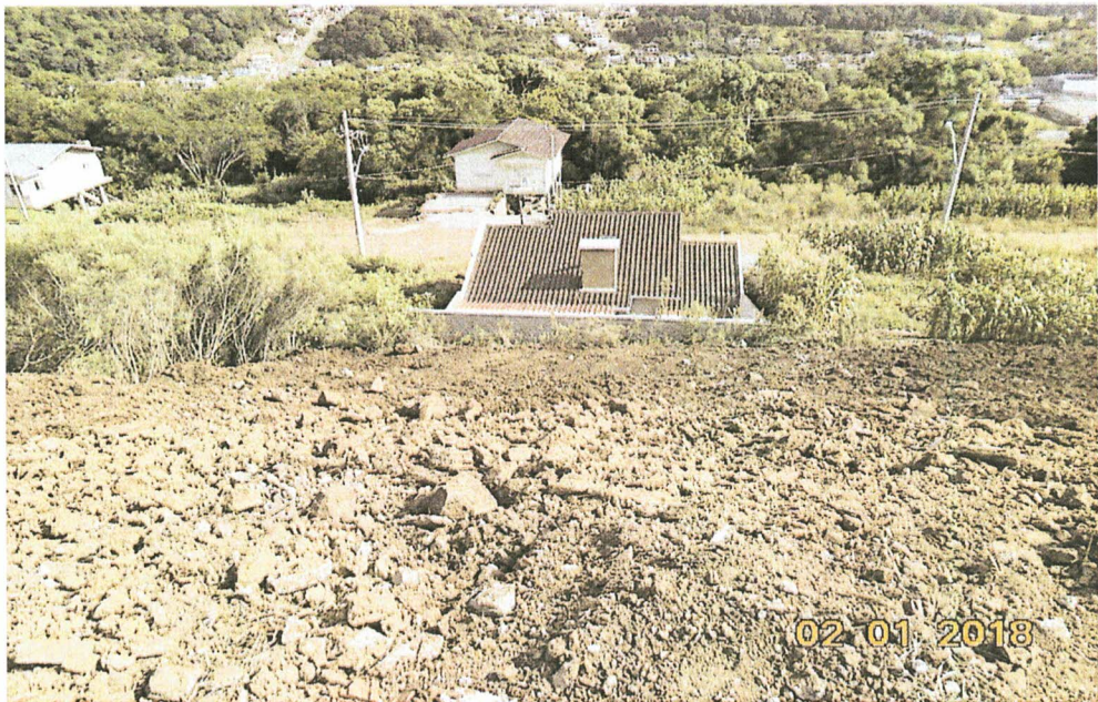
Foto 03 – Demolição Edificação Lote 09 – Quadra F
