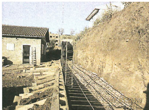
Fotos 21 e 22 – Execução Muro De Contenção – Quadra H
