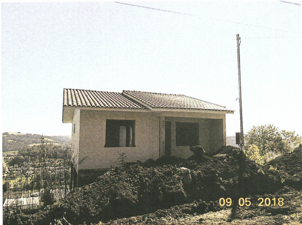
Foto 07 – Demolição Edificação Lote 03 – Quadra G(Rosimara Santos Tavares)
