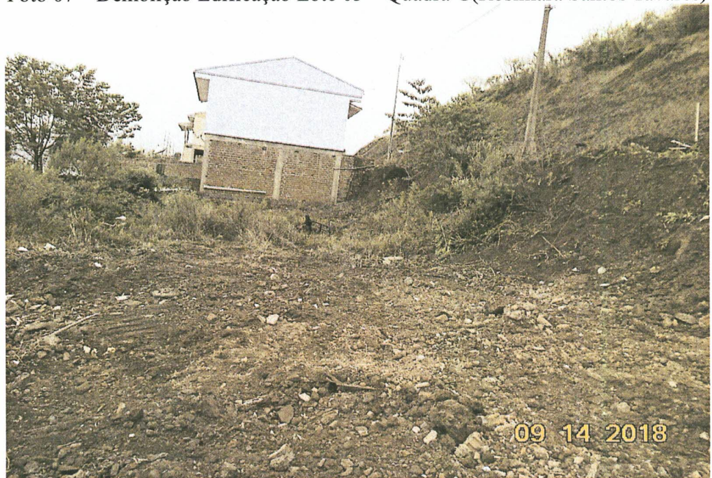
Foto 08 – Demolição Edificação Lote 03 – Quadra G(Rosimara Santos Tavares)
